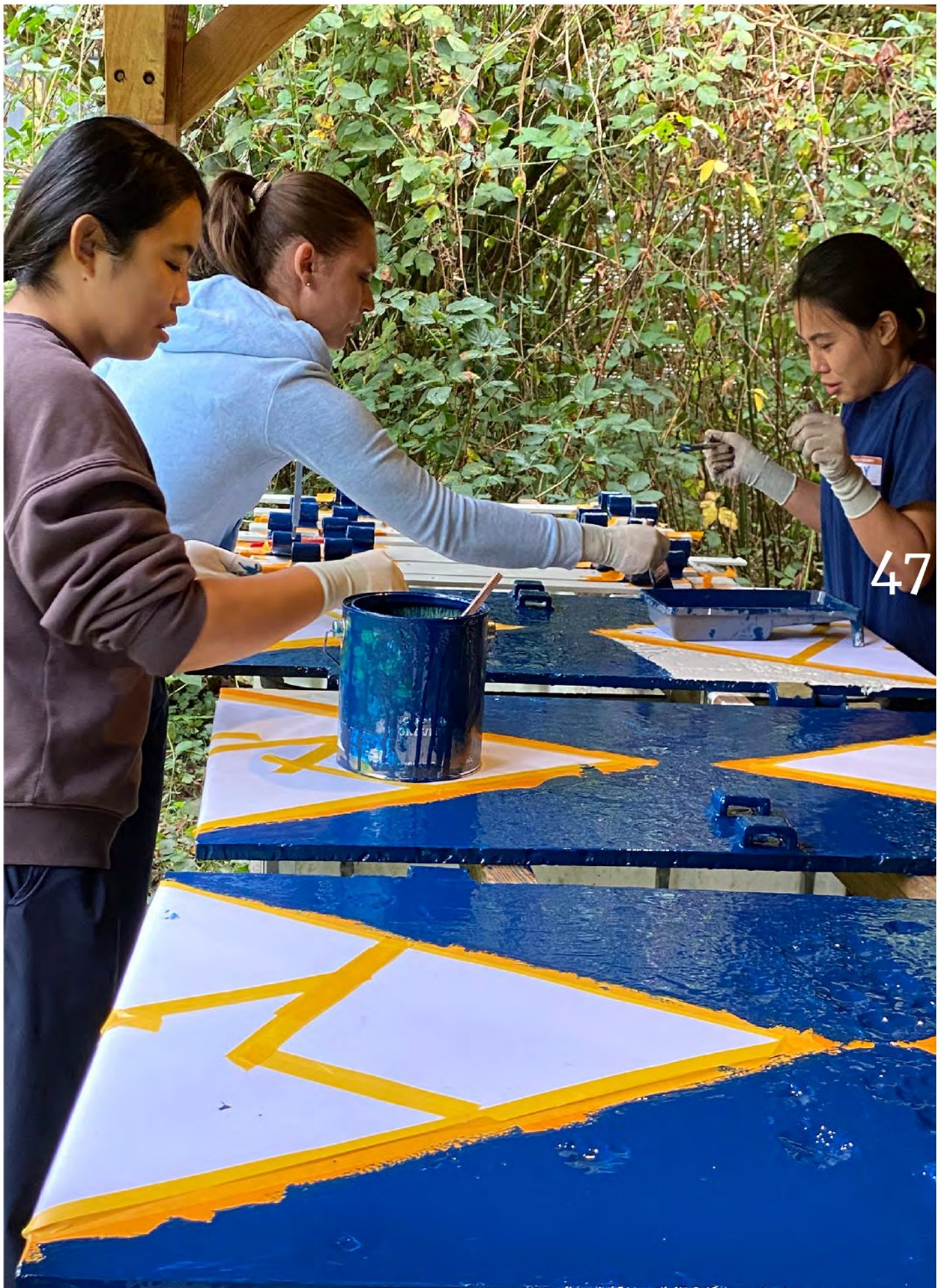
Ontwikkelingen BioArt Village - De volledige buitenschil van gebouw M, N, O, en L zijn volledig hersteld. Hier worden de bomluiken opnieuw in de verf gezet
