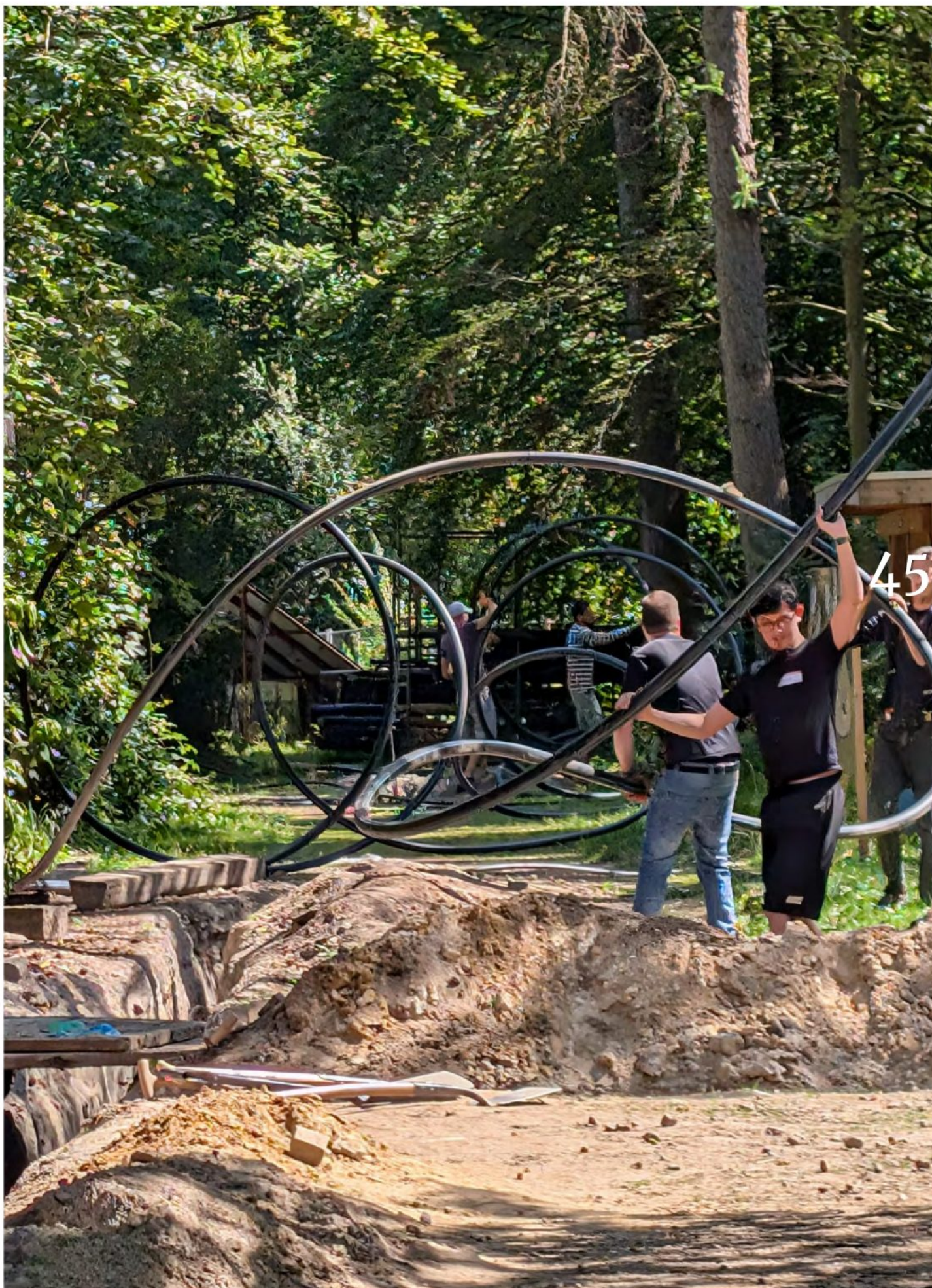
Ontwikkelingen BioArt Village - Volledige vervanging oude ondergrondse infrastructuur, water, gas, elektra, warmtenet, glasvezel en riool.
